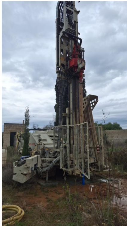
Esecuzione sondaggio S.2 attrezzato a PIEZOMETRO PZ2
